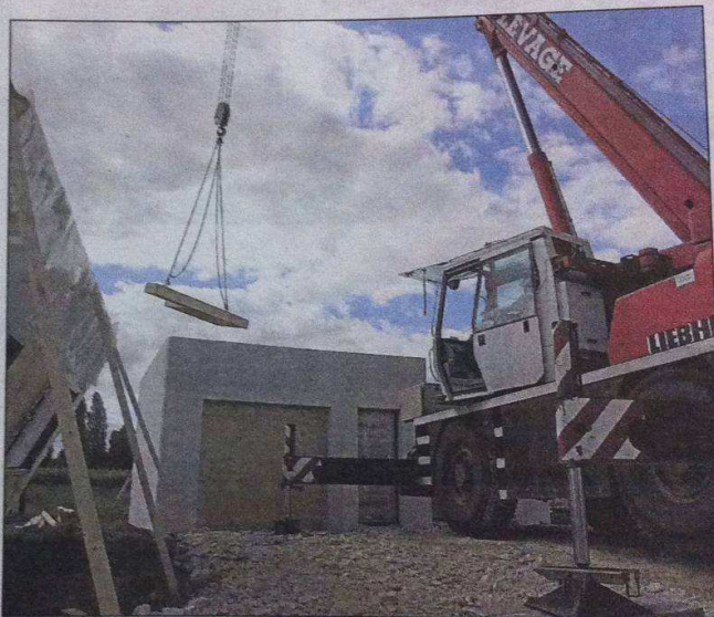
La construction de cette maison à ossature bois sera terminée aujourd'hui.
